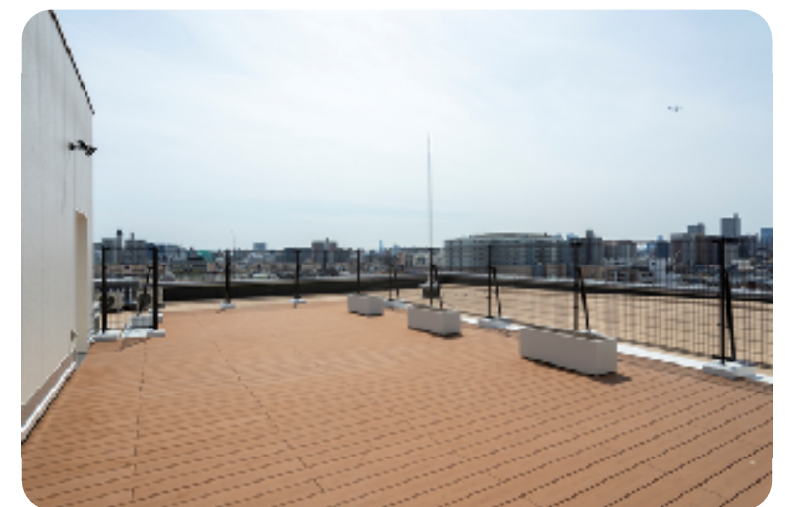
【 晴れ日に撮影した施設の屋上です 】
